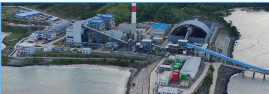
PT Gorontalo Listrik Perdana
